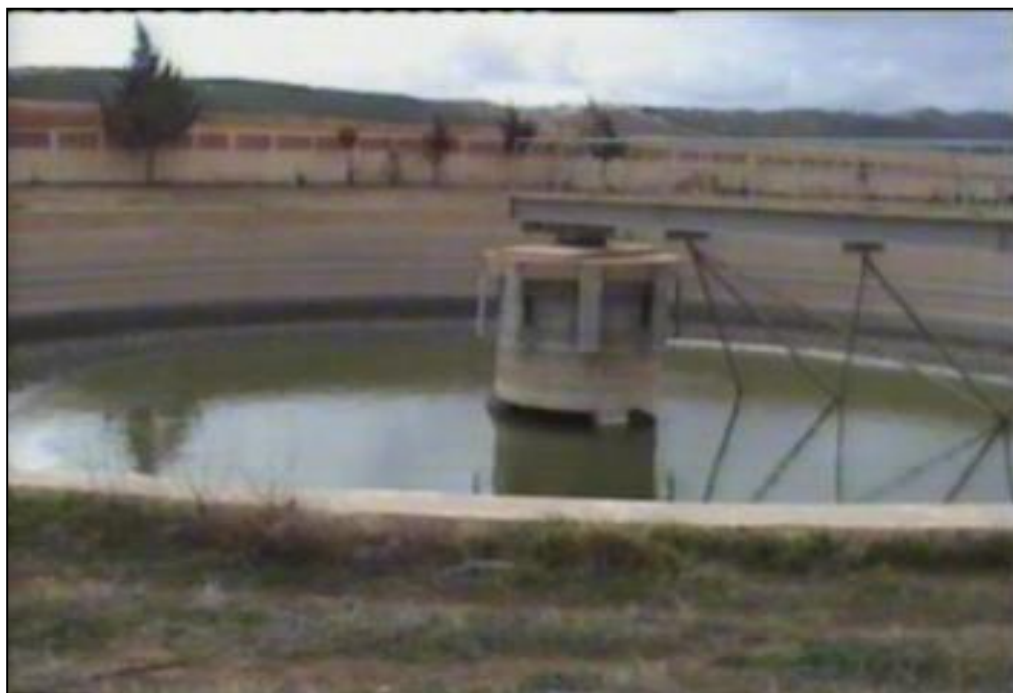
Figure II.11 : Décanteur secondaire n°2
