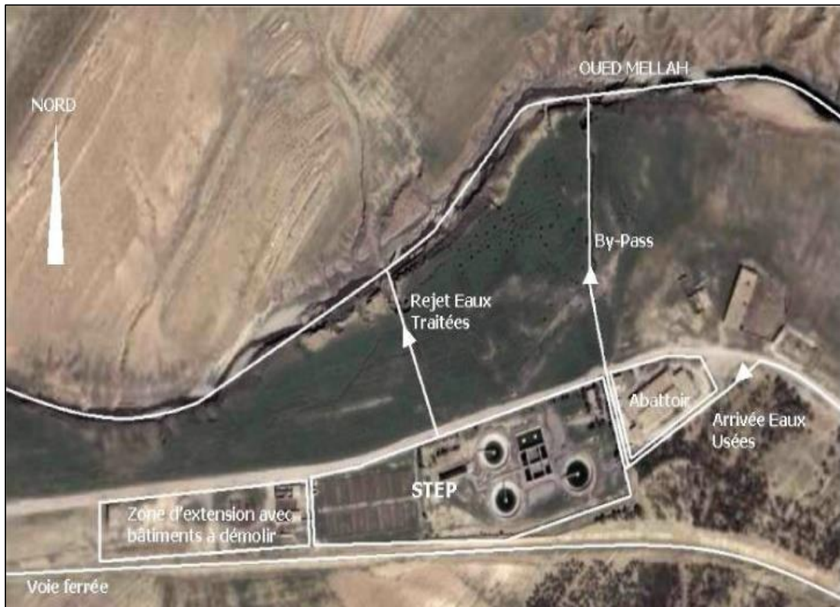
Figure II.3 : Vue aérienne de la station d'épuration et des rejets à l'Oued site prise depuis google earth 2012
