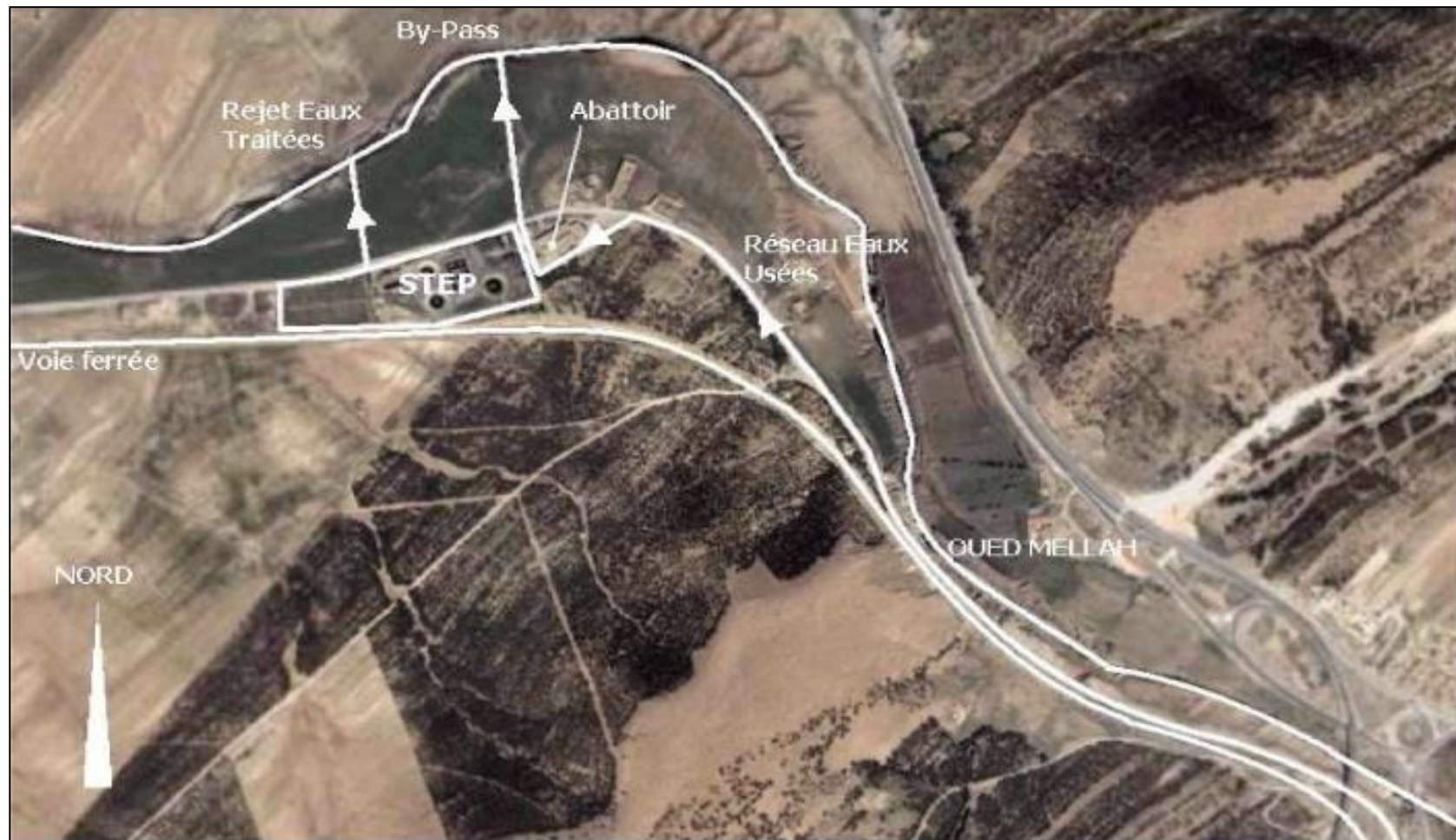
Figure II.2 : Vue d'ensemble localisant le réseau de transfert et la station d'épuration prise depuis google earth 2012
