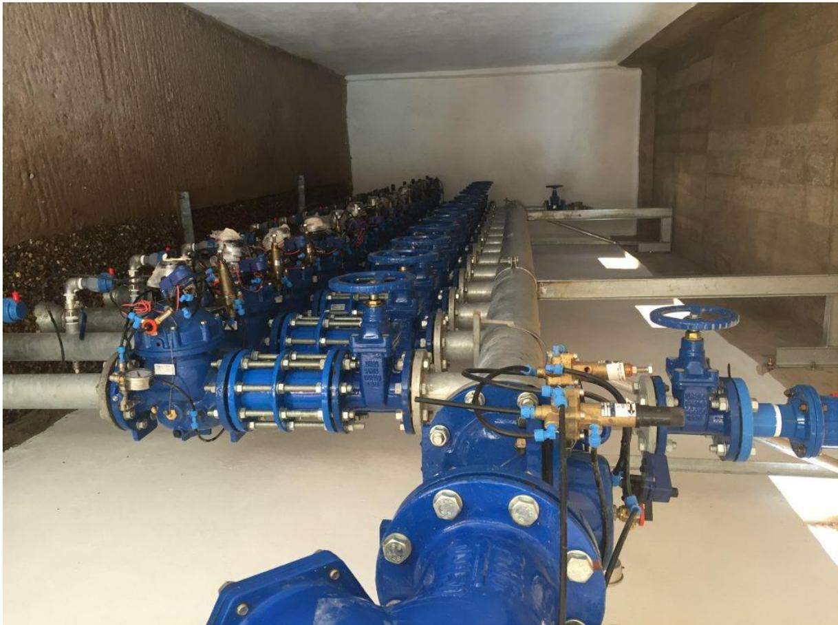
Figure VI. 1: Exemple de borne avec des sorties multiples.
