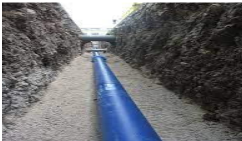
Figure VII.1. Pose de canalisation. (pamline.fr)
