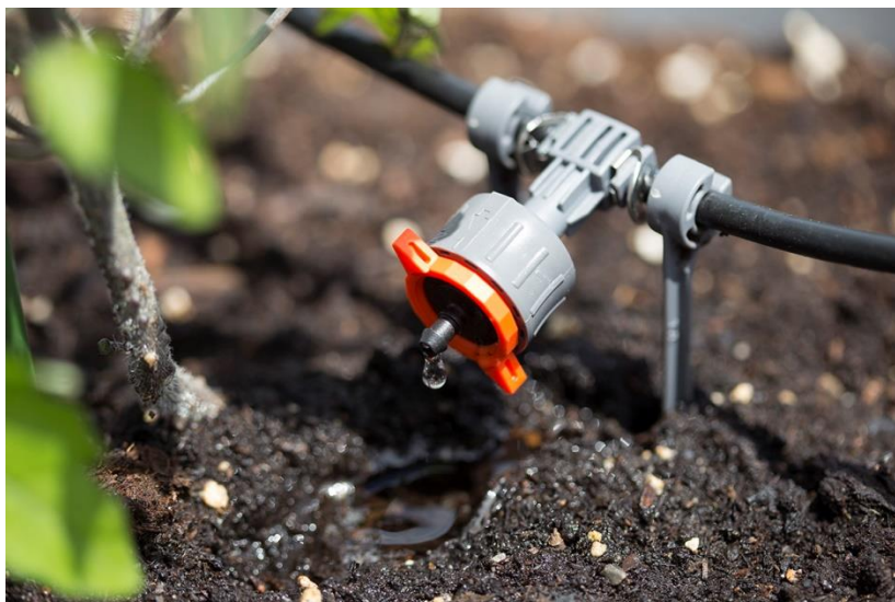
Figure VI.7. : Système d'irrigation goutte à goutte.
