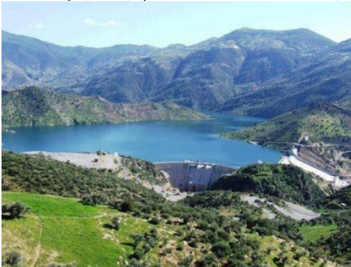
Figure.7. du barrage de Tichy-Haf.
