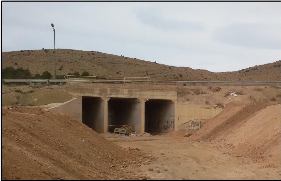
Figure III.1: Des dalots construits au niveau de l'oued pour faciliter la circulation des gens et des véhicules.
