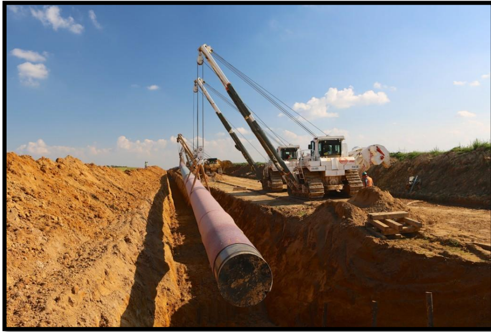
Figure IX-2 Pose de canalisation
