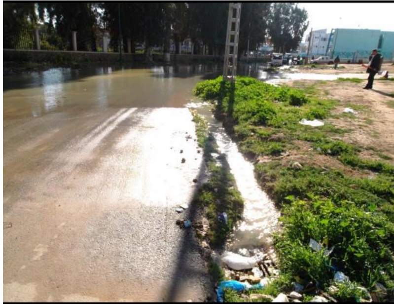
Figure II.8 : La stagnation des eaux pluviales dans le quartier de Ziraia
