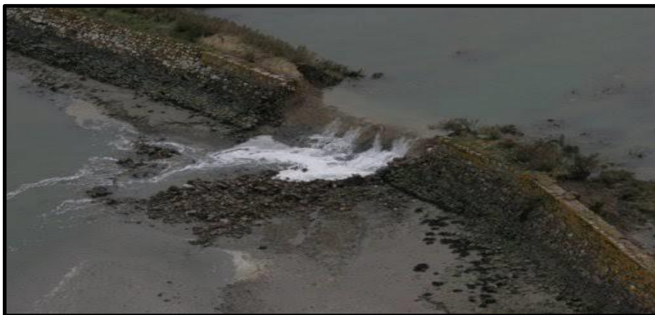
Figure I.11 : inondations par rupture d'une digue ( ppement-durable.gouv.fr )
