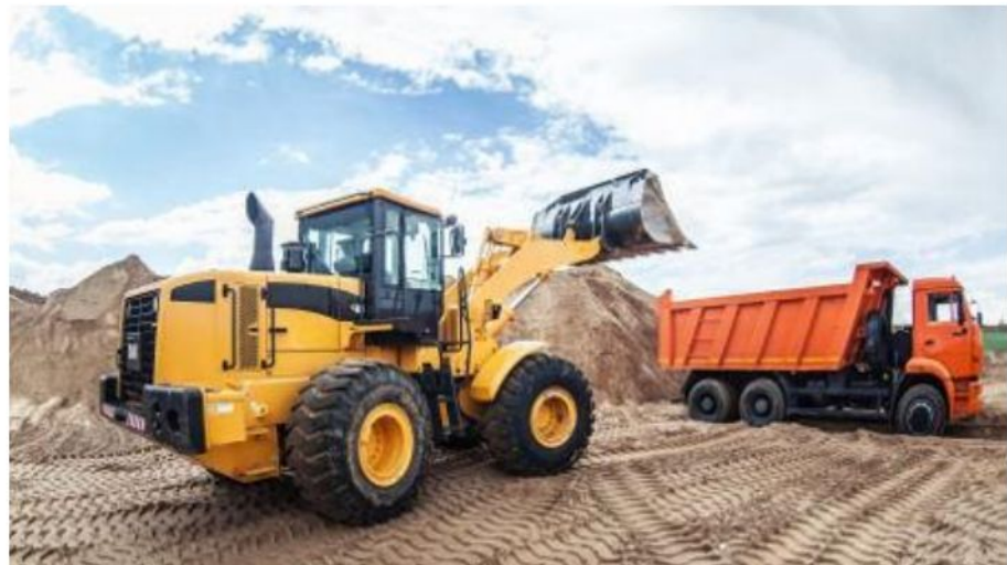
Figure 5.2 : Chargeur et camion pour évacuer les déblais
