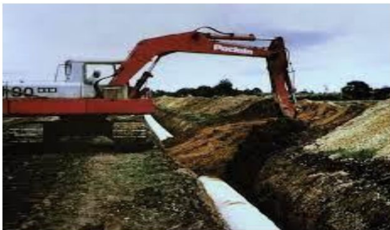
Figure 5.3 : Pose de canalisation et remblaiement
