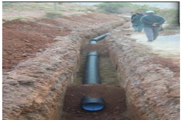
Figure VII.2. pose de canalisation
