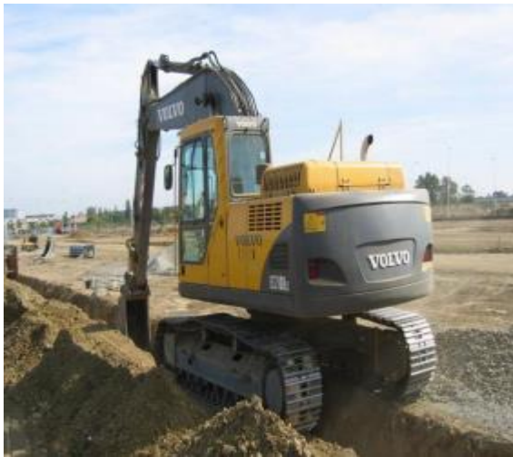
Figure VII.1. Une pelle mécanique
