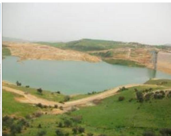
Barrage du KERRADA
