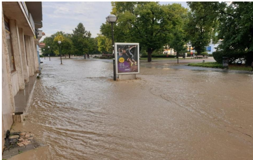
Figure 6 : Inondation par ruissellement dans un secteur urbain.
