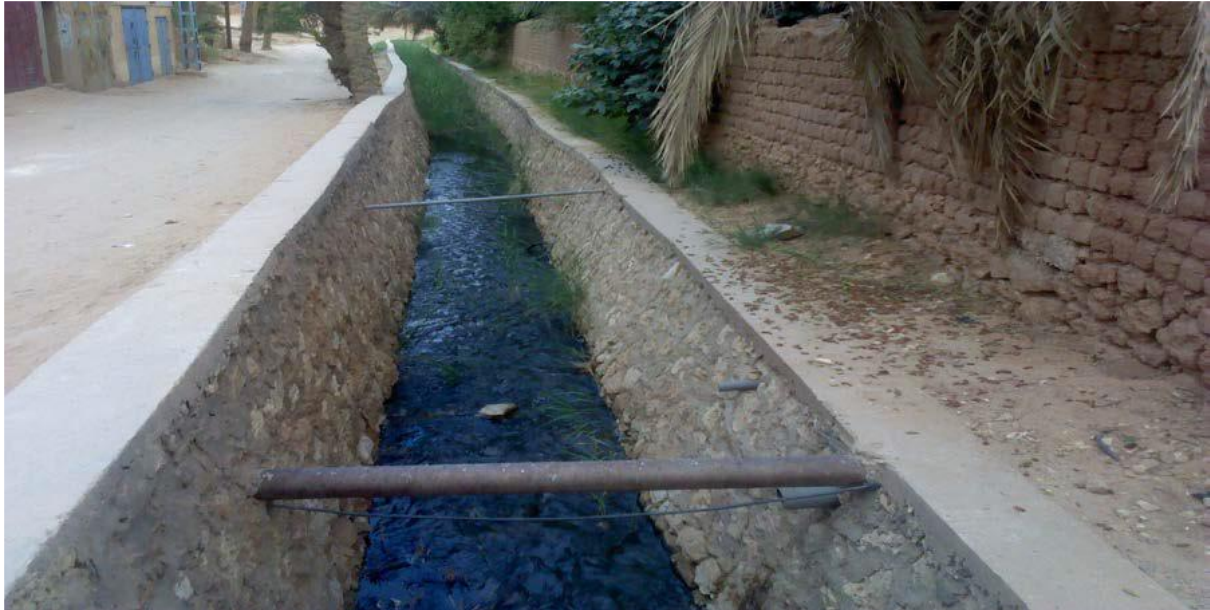
Fig.V.7 Système de drainage El-Menia
