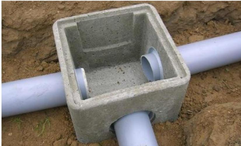
**Figure 29** : Raccordement entre collecteur et collecteur.
