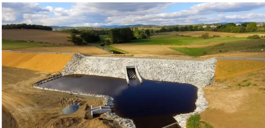
Figure I.7 : Barrage écrêteur ( https://www.le-pays.fr )
