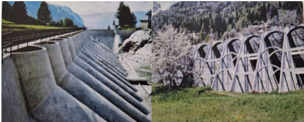
Figure I.18 : Exemples de barrage à voûtes multiples : vue amont du barrage d'Oberems en vue aval du barrage des Marécottes (photo H. Pougatsch)
