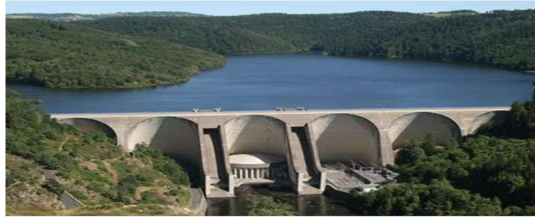
Figure I.19 : Barrage à contrefort au Québec ( https://barrage-tpe.jimdofree.com )
