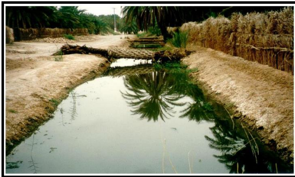
Figure IV.4 : drainage par fossé
