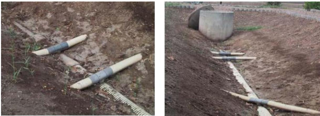
**FigureIV-8:** Raccordement drain – collecteur
