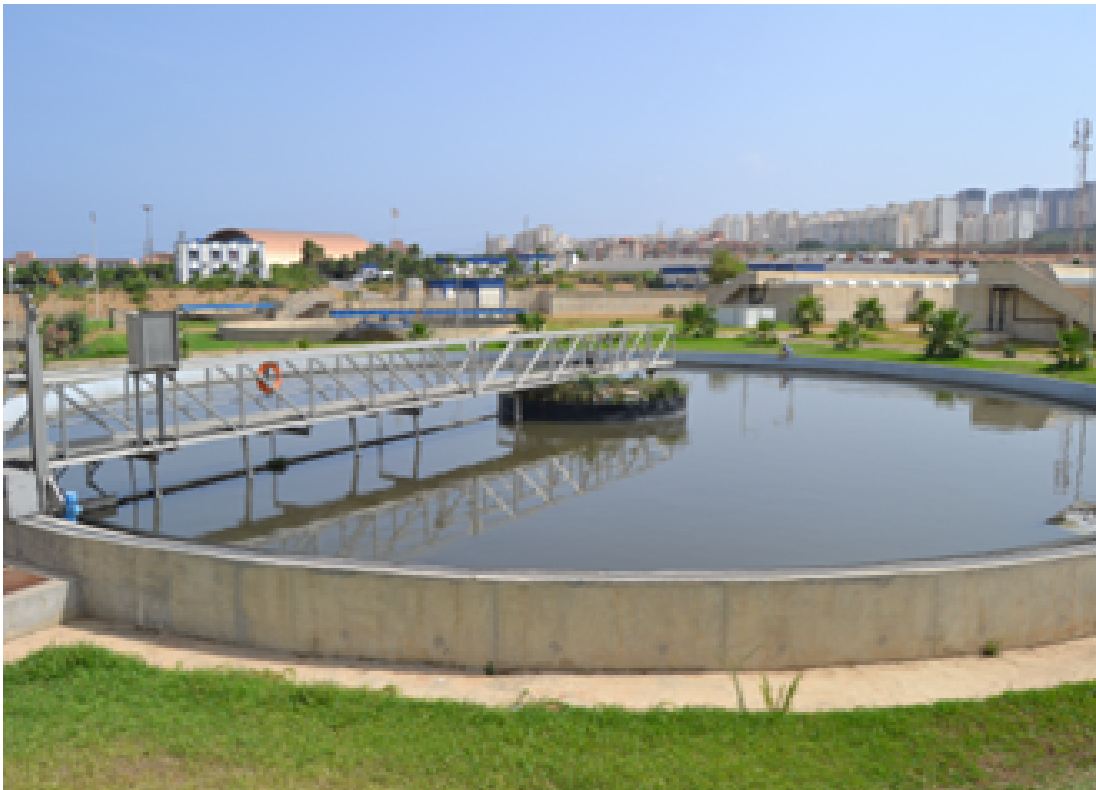
FIG. 2.5 : Décanteur primaire.
