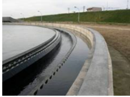
Surverse d'un clarificateur
