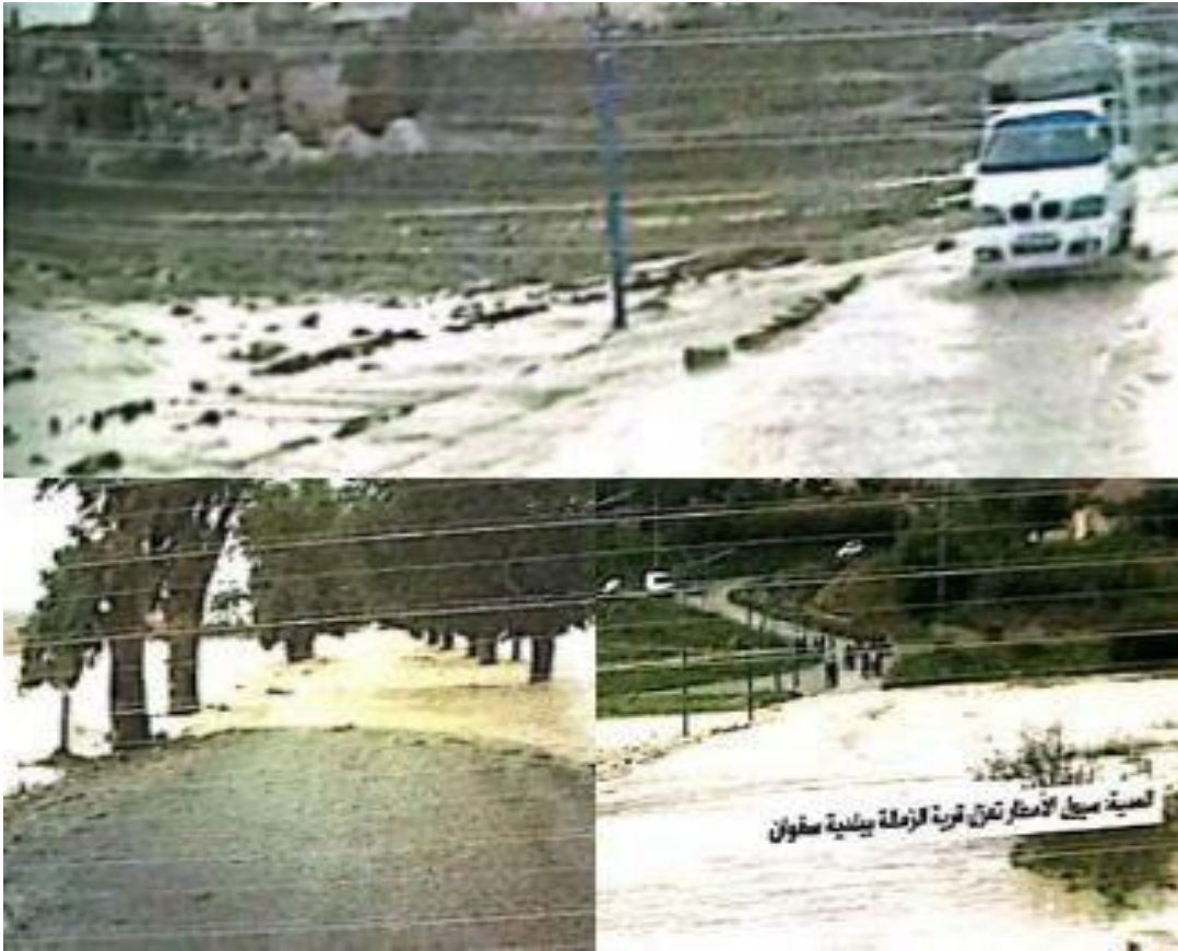
Figure II.9 : Inondation de la commune Seghouane cité z'mala.
