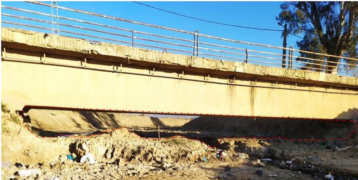
Figure V.18 : Ouvrage de franchissement N°2.
