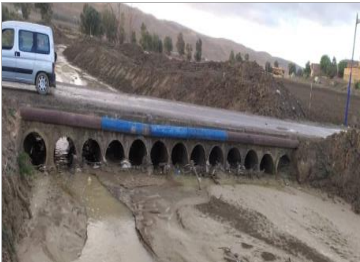
Figure V.11 : Ouvrage de franchissement N°1.
