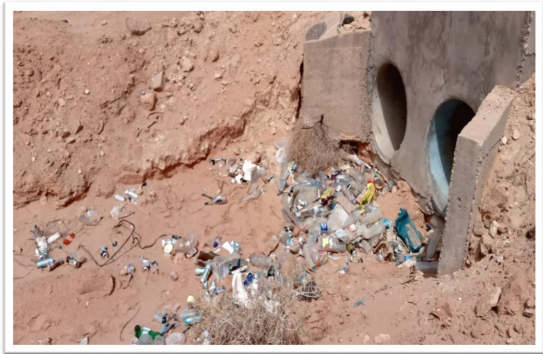
Figure.V.16 : L'état actuel de l'ouvrage.
