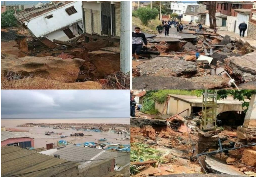
Figure.III.11 : Les dégâts des inondations de Tipasa (journal El Moudjahid).
