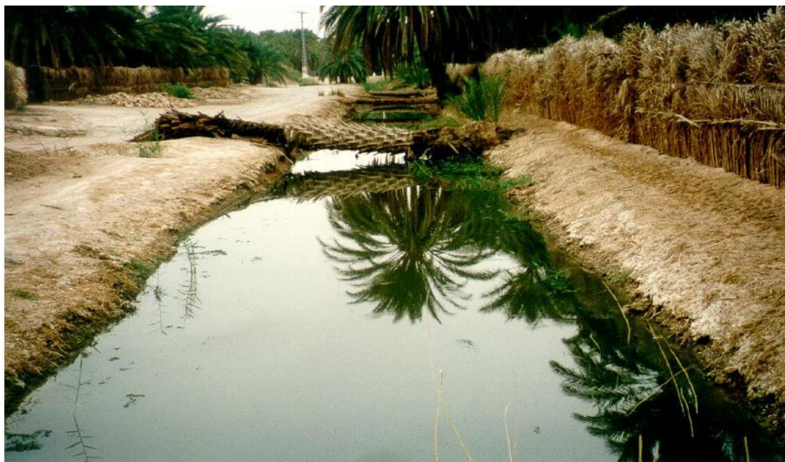
Figure 27 drainage par fossé Ouargla (Source : rapport BG 2004)
