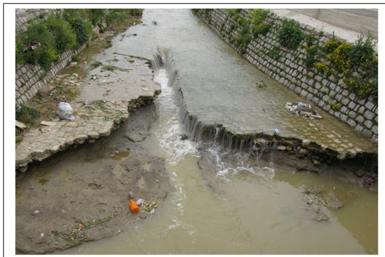
Figure IV.2 : Détail d'un canal maçonné à l'amont du pont
