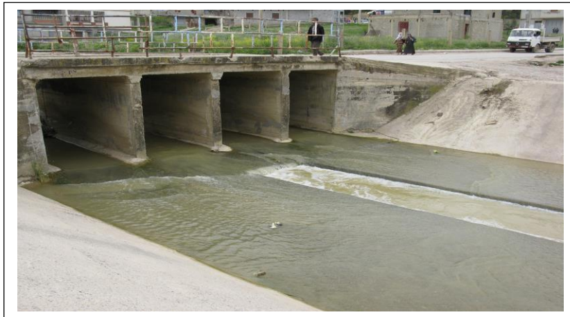
Figure IV.4: Détail du bief aval du pont
