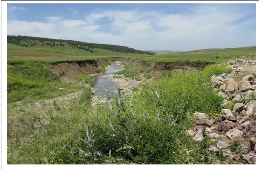
Figure IV.6 : Tronçon à l'aval d'un ouvrage busé sur la route
