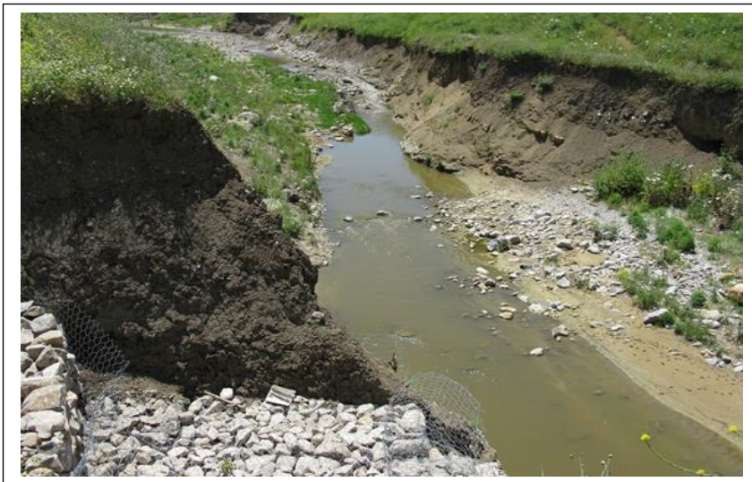
Figure IV.7 : Lit de l'oued après d'un ouvrage busé sur la route
