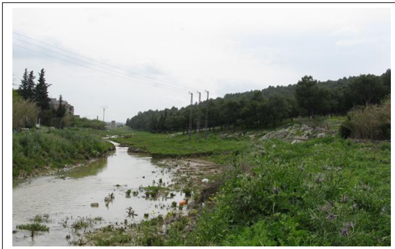
Figure IV.1 : Tronçon de l'oued Sigus à l'amont du début de l'aménagement
